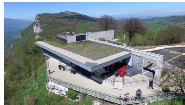
Belvédère-restaurant La Chambotte, Savoie
